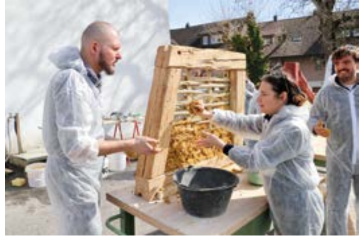
Hand anlegen für den Aufbau einer Lehmwand.
